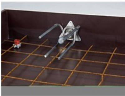
Figuur 37: Deuvel in een betonvloer voor de stort.
