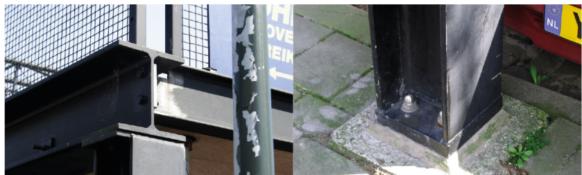
aansluiting tussen HE ligger en IPE ligger op en HE kolom
