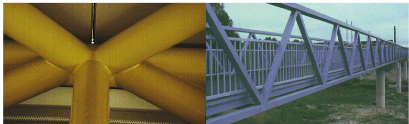
knooppunt van ruimtelijk vakwerk vervaardigd uit holle buizen
