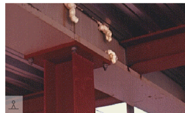
opgelaste kopplaat met vier bouten buiten het profiel geplaatst
