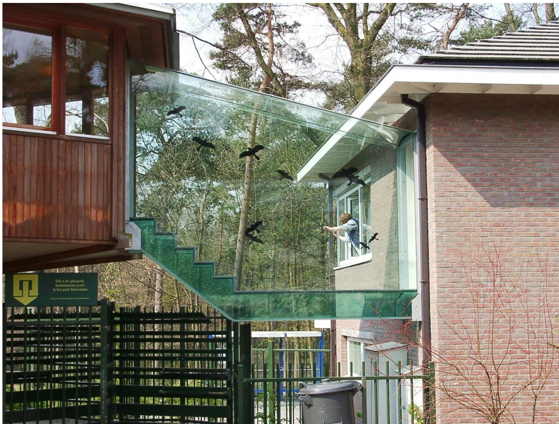
Verbindingsbrug tussen twee gebouwen van de dierentuin Arnhem; Burgers ZOO. Een echte, bijna volledige glasconstructie.
