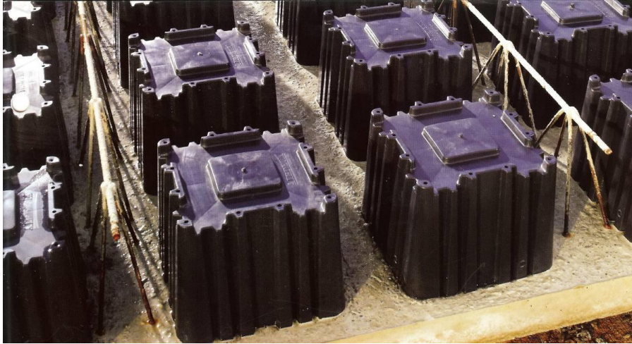
Airdeck vloer in plaats van bollen dozen op de geprefabriceerde vloerplaat geplakt.
