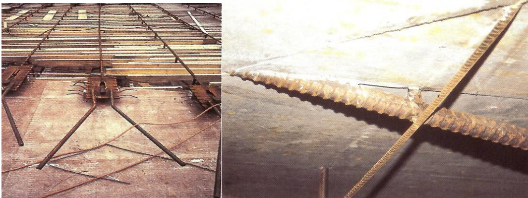
Verankering van trekkracht in beton (links) en de mysterieuze wapeningsstaaf die uit het beton komt (rechts).
