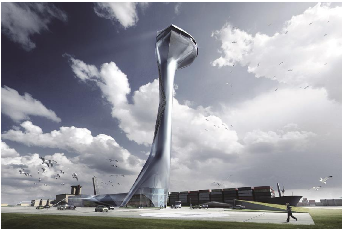
150 meter hoge toren voor het coördinatiecentrum rampen bestrijding haven Antwerpen. Ontwerp UNStudio. De toren is zo aerodynamisch mogelijk gemaakt en leunt ietwat in tegen de overheersend Zuidwesterstormen.
