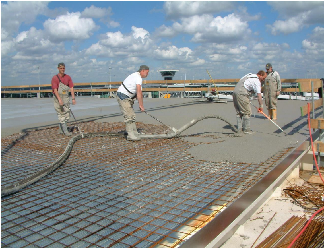
Staalplaat betonvloer: storten van beton op geprofileerde staalplaten (Schiphol).
