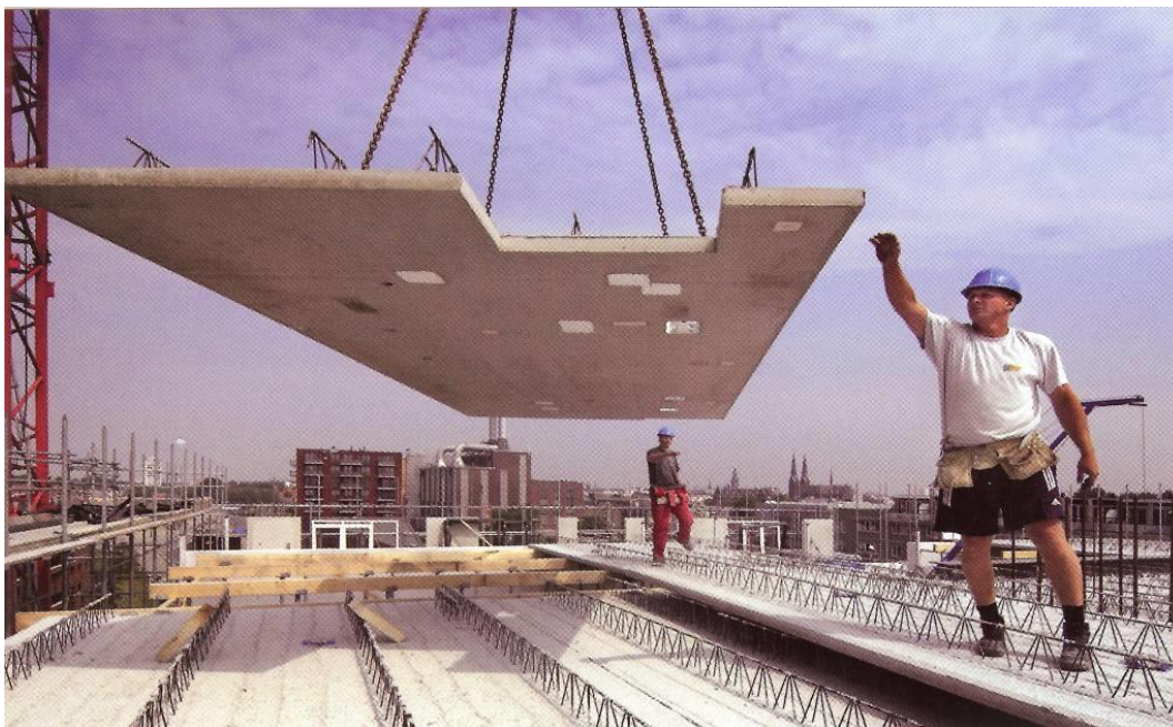
Breedplaten arriveren op het werk, met hoofdwapening in de plaat en de sparingen voor trapgaten en lichtdozen.
