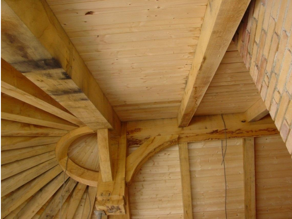
Een voorbeeld van een massief houten kapconstructie uit delen, gezaagde boomstammen opgebouwd.
