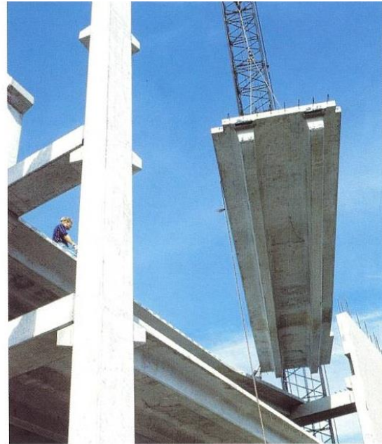
Montage TT-knikplaat
