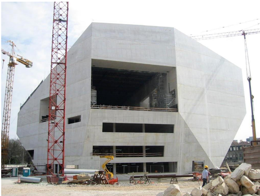
Casa da Musica in Porto (Portugal) van architect OMA. Bouwfase in 2003 met wit betonnen constructie.
