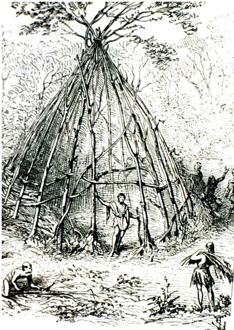
Eén van de eerste bouwwerken van de mens, een hut opgebouwd uit takken. Door het samenbinden aan de top en het verankeren in de grond is de hut stabiel en kan bekleed worden met bladertakken, dierenvellen of doek.
