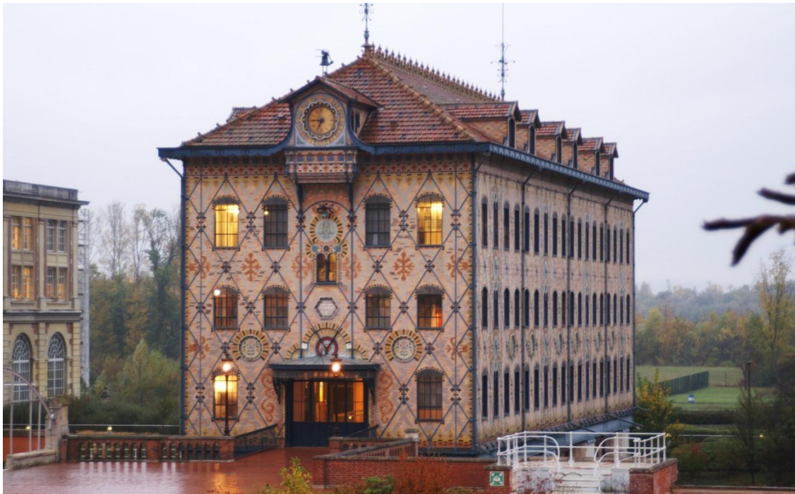
Rijk gedecoreerd metselwerk in gevel Chocoladefabriek Menier in Noisiel (Frankrijk). Overigens heeft het uit 1872 daterende gebouw een ijzerskelet als draagconstructie en het metselwerk slechts een scheidende functie.
