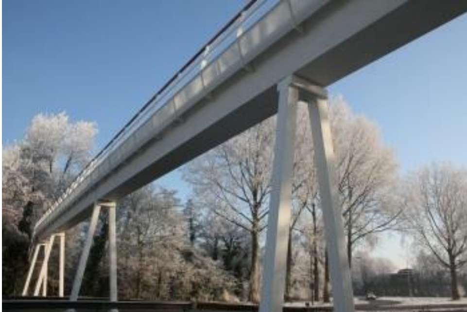
Voorbeeld van een kunststof (composiet) viaduct.
