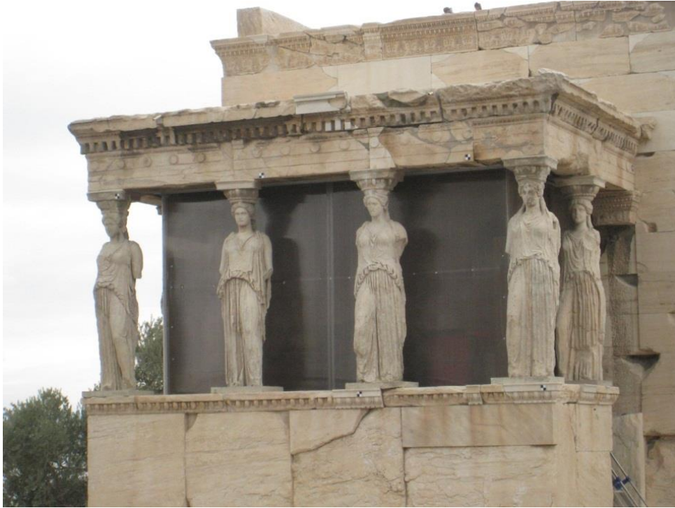
Akropolis in Athene, de kariatiden die het dak van de Erechthion tempel dragen.
