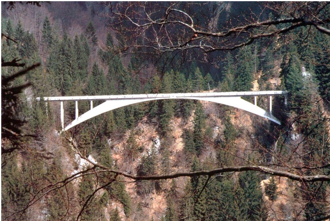
Een prachtig vormgegeven betonnen boogbrug in Zwitserland, de Saginatobel brug van arch./ing. Robert Maillart, gebouwd rond 1930.
