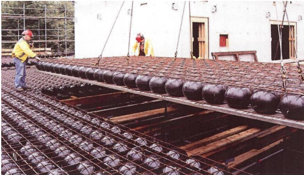
Een bollenvloerplaat (Bubble-deck) met ook de bovenwapening erop, arriveert op de bouwplaats.
