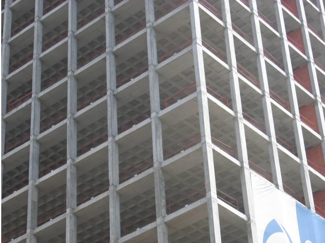
Een flatgebouw in aanbouw, ter plaatse gestorte balken en kolommen met een cassettevloer tussen de balken.
