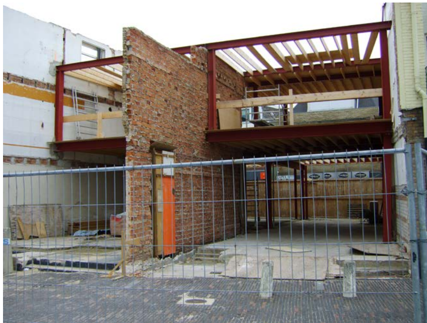
Renovatie winkelpand, Woerden
