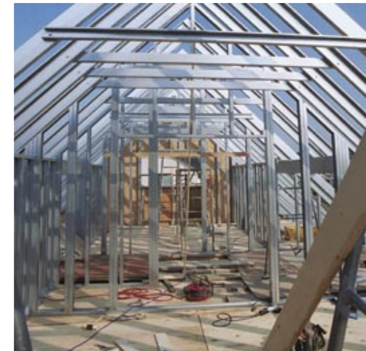
10. Draagconstructie van een zolderverdieping van koudgeformde staalprofielen (The Japan Iron and Steel Federation, Japan).
