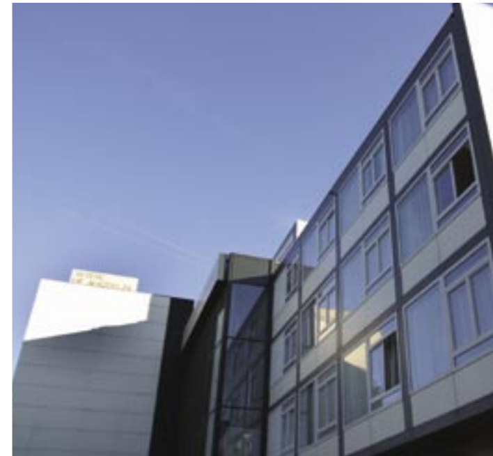
HEM-hotel in Amsterdam. Als een zelfdragende 'carrossie' zijn vier bouwlagen van staalframebouw opgetrokken.
