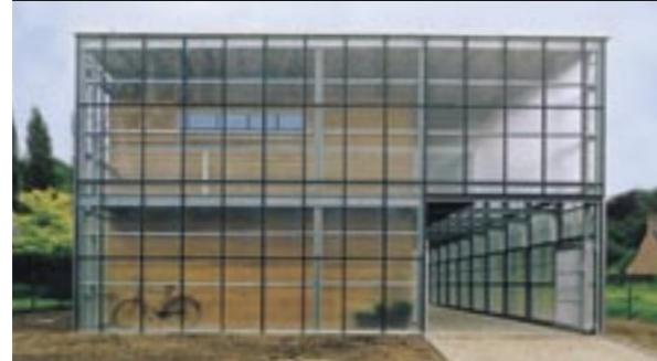
5, 6, 7. Gebouwen van staalframebouw met de staalconstructie in het zicht (Sadef, België).
