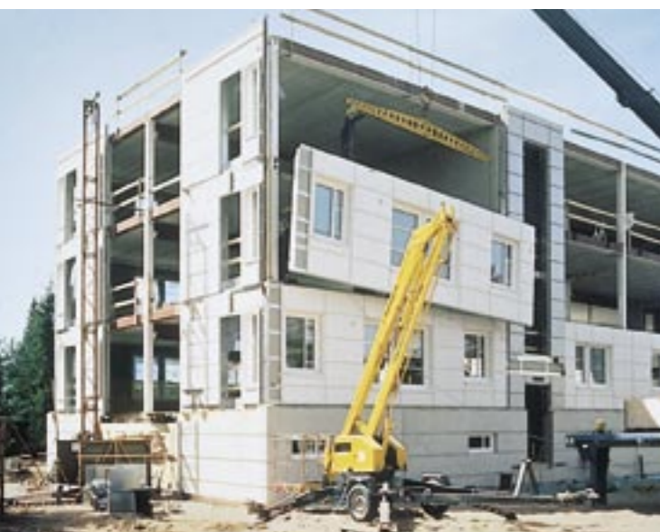
47. Montage van geprefabriceerde elementen (Rautaruukki Oyj, Finland).
