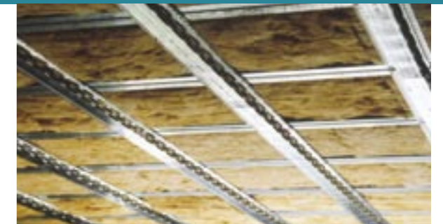
56. Geluidsarme veerregels als akoestische ontkoppelde bevestiging van het plafond aan de vloer (Profilhaus, Ettlingen).
