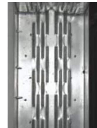
81, 82. Een 'thermoprofiel'. De sleuven in het lijf verlengen de 'weg' van de warmtestroom en voorkomen koudebruggen.
