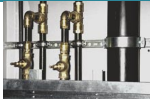
70. Geluidarme bevestiging van leidingen in een metalstudwand.
