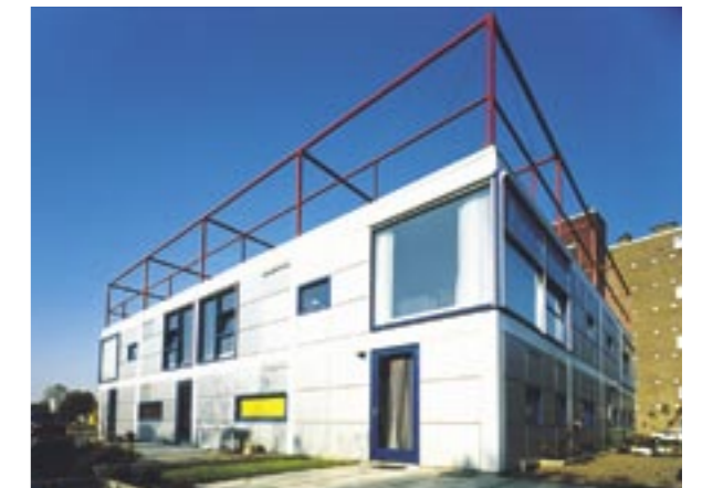
17. Woningen met een hoofddragconstructie in staalframebouw (Dedemsvaartweg, Den Haag).
